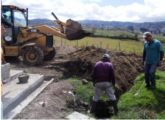
Mit den Maschinen der Stadtverwaltung wurde der Entwässerungskanal ausgehoben
