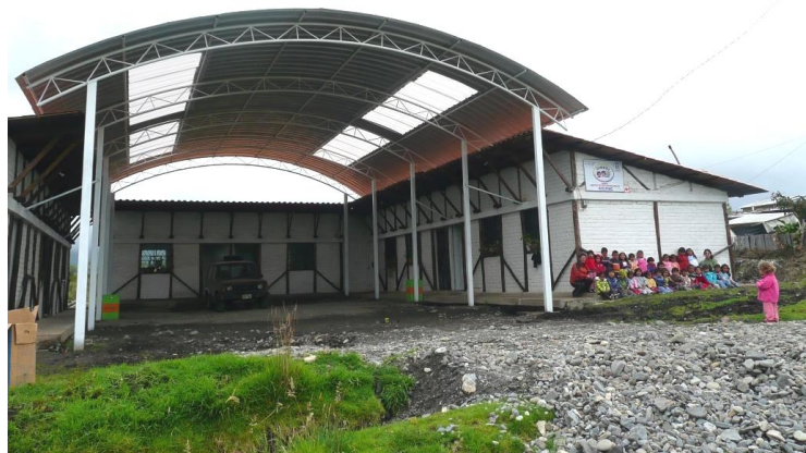
Endlich ist der Bau fertig und die Kinder werden in den neuen Klassenzimmern unterrichtet
